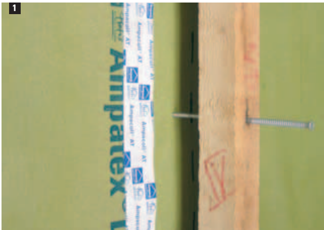
1 Ampatex® DB 90, Überlappungsverklebung mit Ampacoll® AT.
