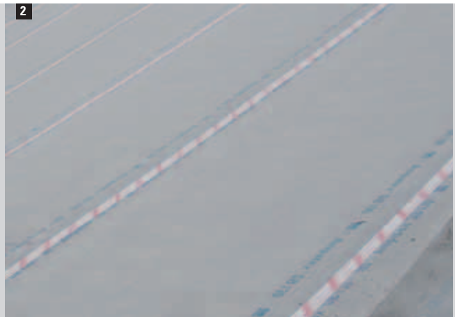
2 Ampatex® SB 130, Schalungsbahn, Überlappungsverklebung mit Ampacoll® XT
