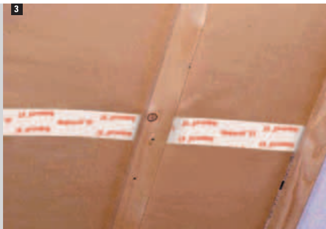
3 Sisalex™ 500, Überlappungsverklebung mit Ampacoll® XT.
