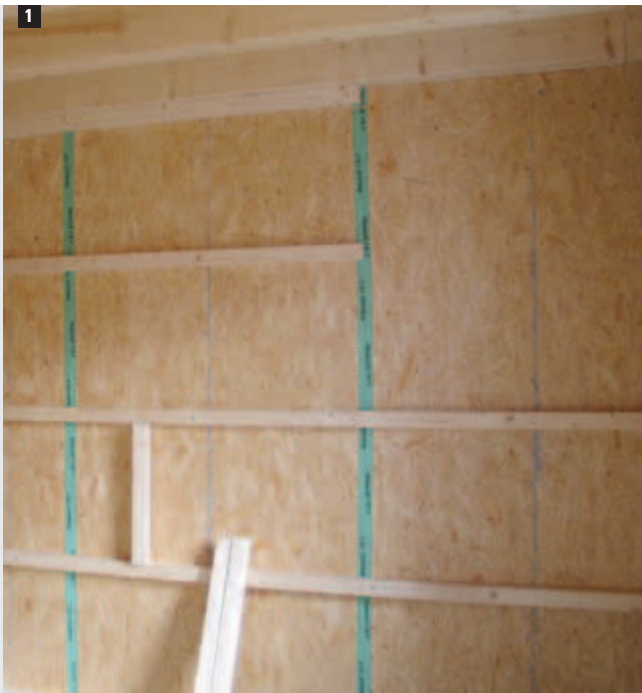
1 Luftdichte Verklebung von OSB-Platten mit Ampacoll® I.N.T.
