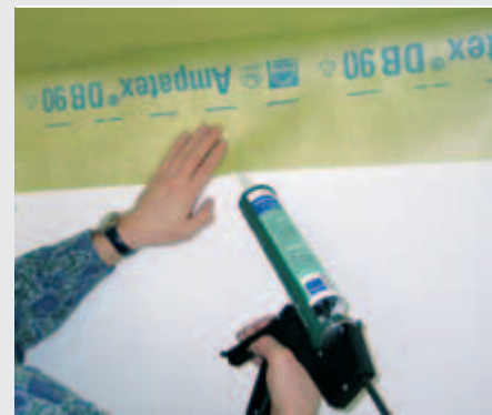
2 Ampatex® SB 130, Schalungsbahn, Überlappungsverklebung mit Ampacoll® XT
