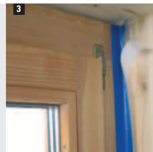
3 Fensteranschluss im Mauerwerksbau mit Ampacoll® BK 535.
