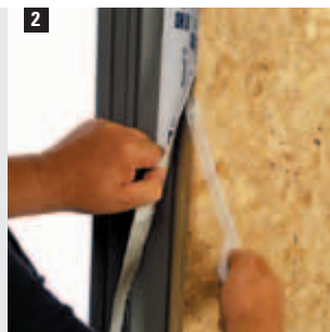
1 Anschluss Dampfbremse und Luftdichtungsschicht an Dachflächenfenster mit Ampacoll® FE.
